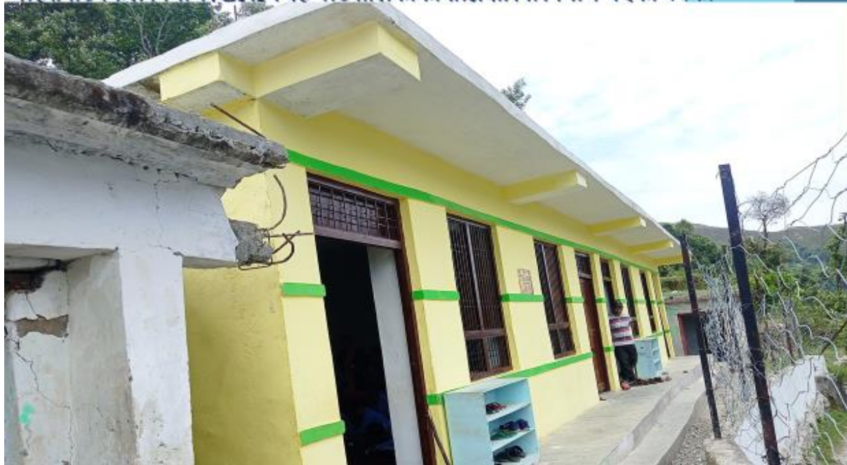
बोहरीगाउँ स्कल निर्माण (GNI र दहँ गाउँपालिकाको साझेदारिमा निर्माण भएको बनेको
