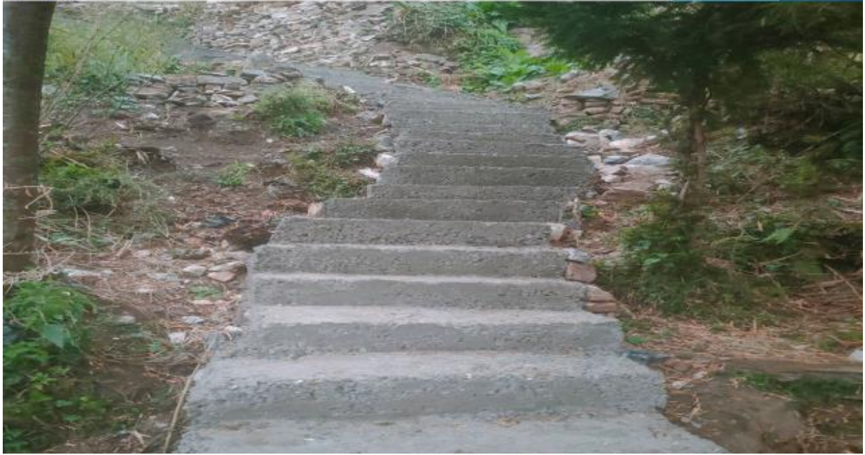
ठुलढुङ्गा देखि बकरओडार चिनाडी सम्मको PCC बाटो निर्माण
