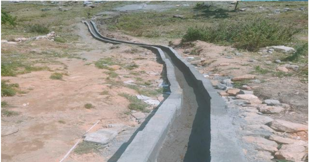
सिमार ढल निकास निर्माण
